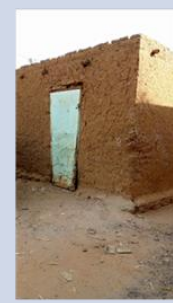
Avant la réhabilitation
