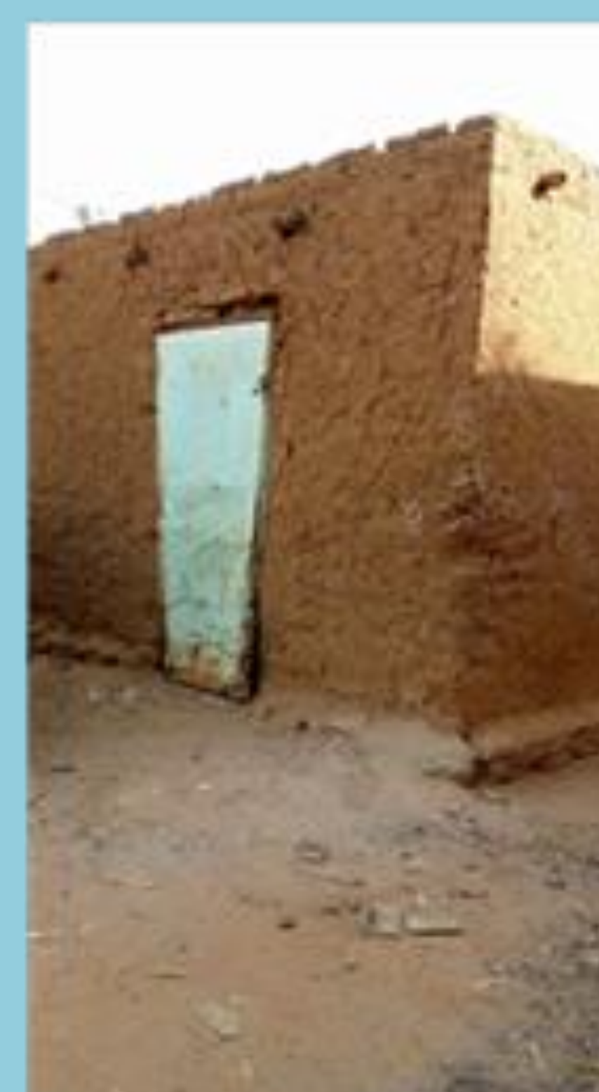
Avant la réhabilitation
