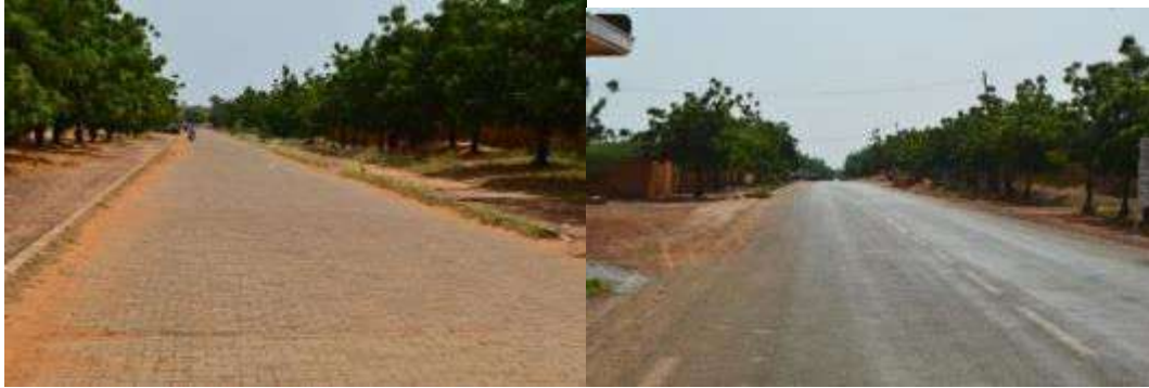
Photo 2. Site potentiel proposé pour l'éclairage public dans le cadre du PIDUREM (Commune d'Illéla -Région de Tahoua)
