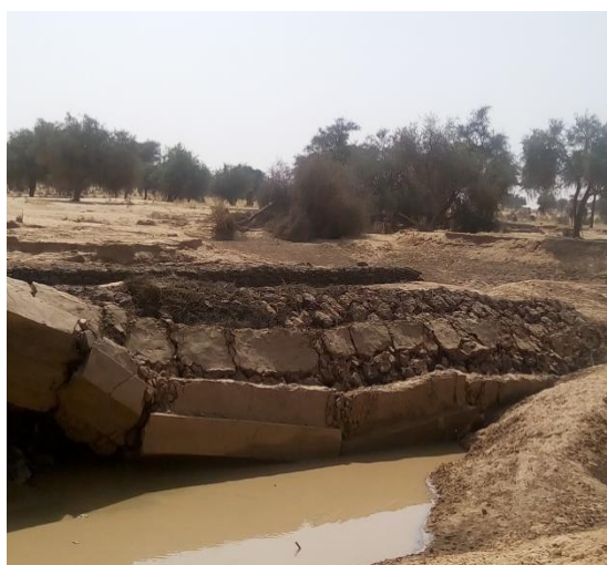
Photo «3 : Effondrement de la digue de protection (Bermo) Photo 4 : Vue de la mare de Orobandji Lit de la mare de Akadané
