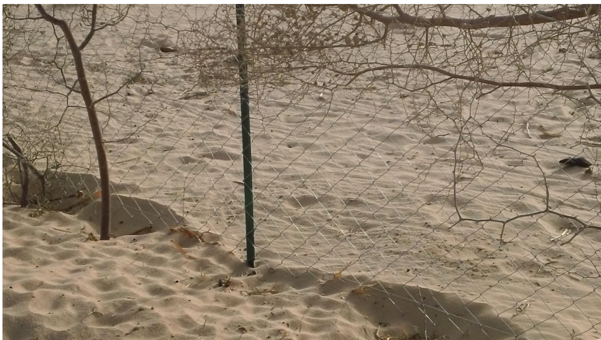
Fig. 22 : Ensablement du site d'Ajeguirdo
