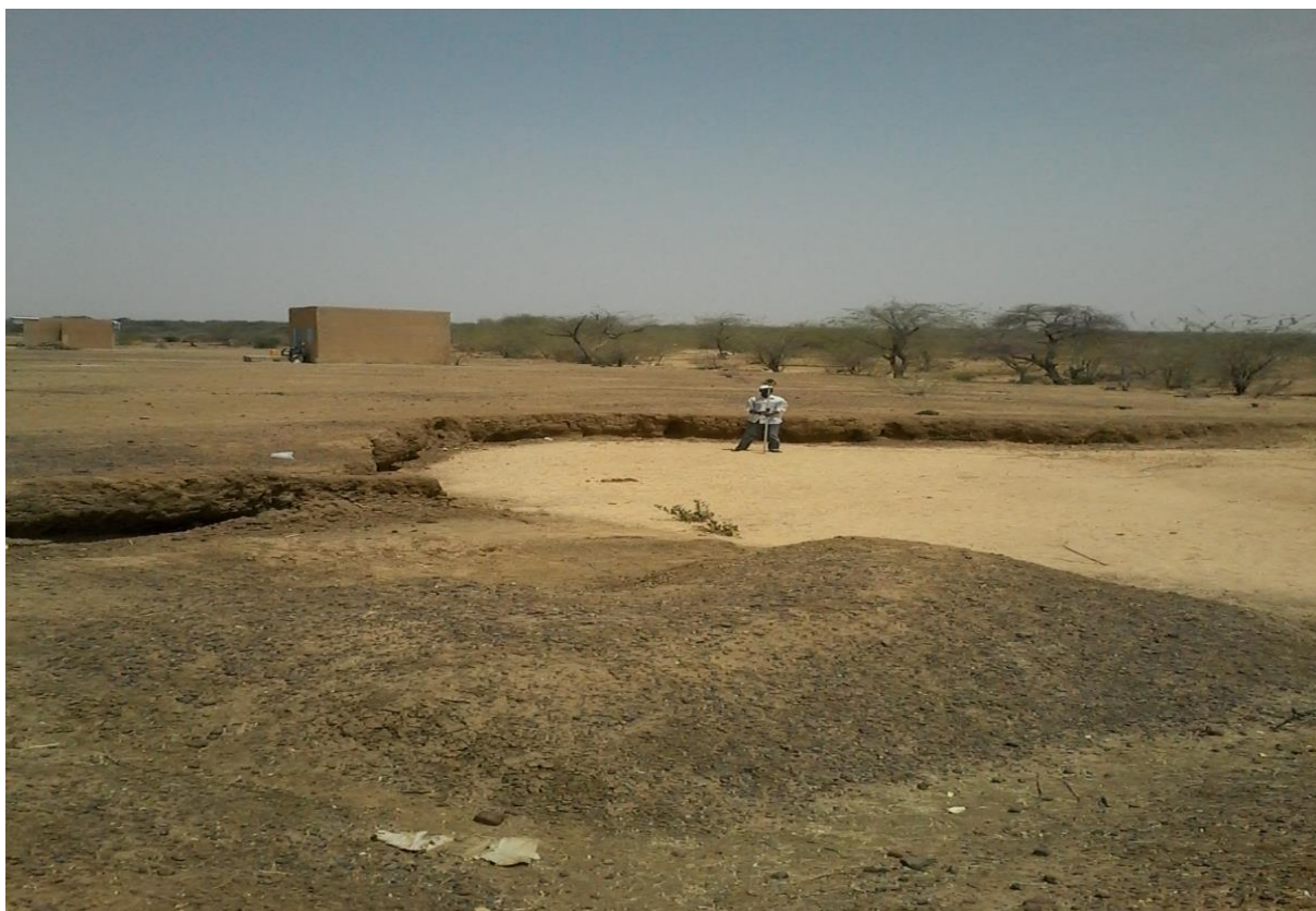
Fig. 32 : Erosion régressive de la berge qui menace la maison du paysan
