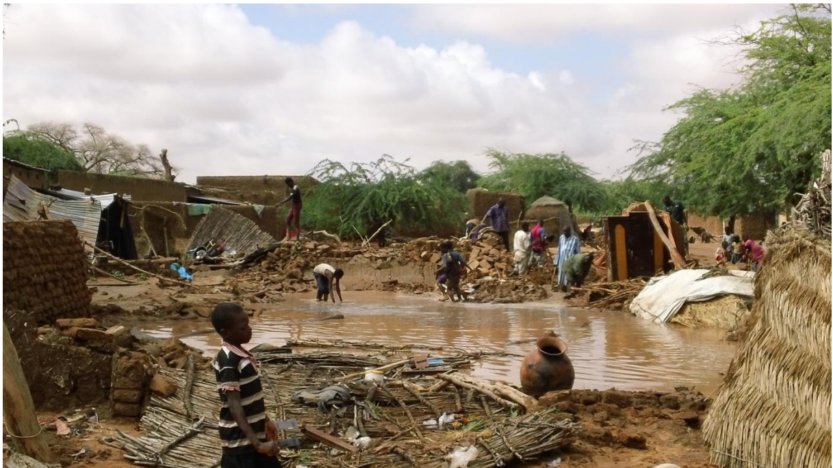
Fig.11 : Effondrement des maisons dans la ville de Dakoro
