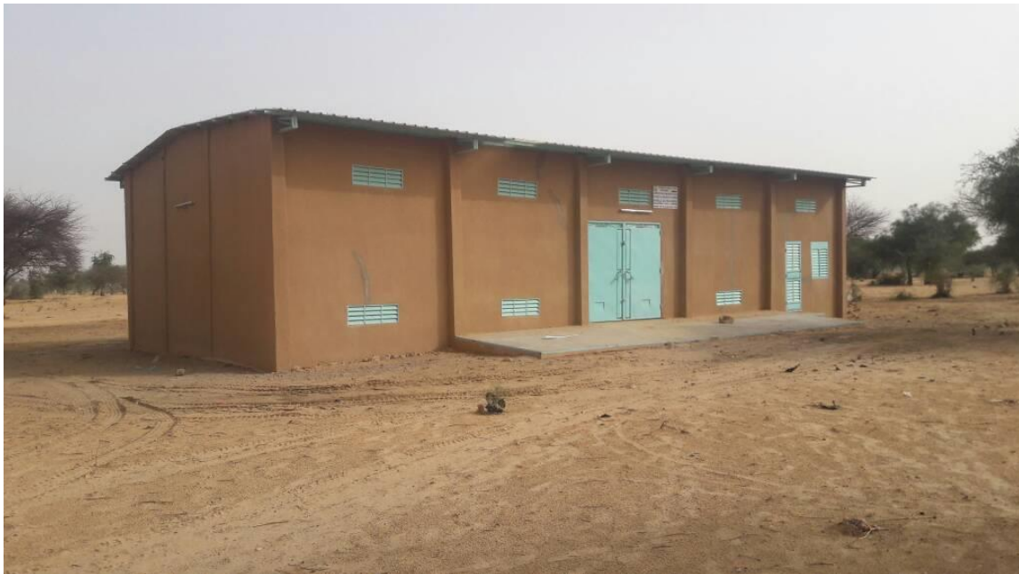
Photo 11: Magasin de stockage de 200T dans le cadre de la « maison du paysan » de la commune de Roumbou 1
