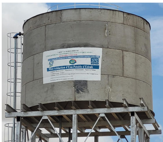
Une vue du réservoir de la mini-AEP
